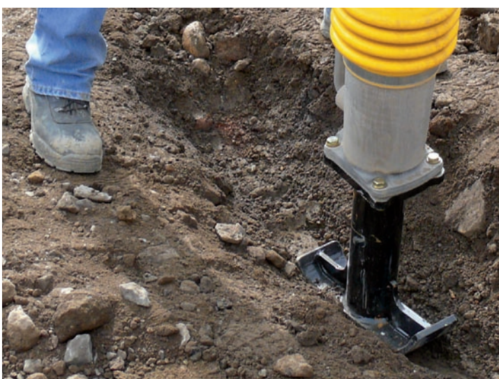
Unterschiedliche Stampfußverlängerungen (optional) selbst für sehr schmale Kabelkanäle.
