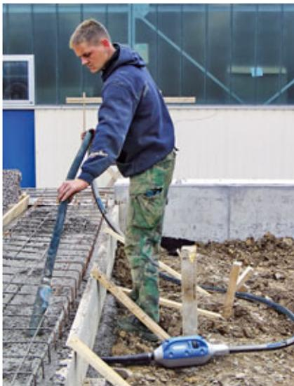
**Für die Betonverdichtung – auf professionellen Baustellen – sind die IVUR-Hochfrequenz-Innenvibratoren mit elektrischem Umformer die ideale Lösung.**
